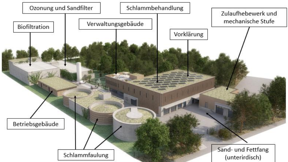
Abbildung 2: Die neue ARA Seeland Süd und ihre Verfahrensstufen / Anlagenobjekte (Visualisierung: Rykart Architekten AG)
